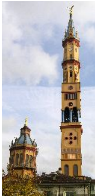
Francesco Faà di Bruno, campanile della chiesa di Santa Zita, 1863-1876, Torino, via San Donato
